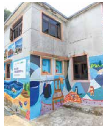
大埔地質教育中心 Tai Po Geoheritage Centre
